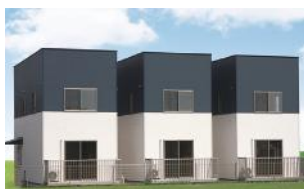
栃木市西方町金崎/3棟 平成24年完成(満室)
