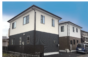
小山市城東/2棟 令和2年完成(満室)
