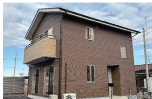
宇都宮市下岡本町/1棟 令和6年2月完成(満室)
