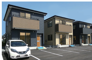
宇都宮市平松本町/3棟 令和5年4月完成(満室)
