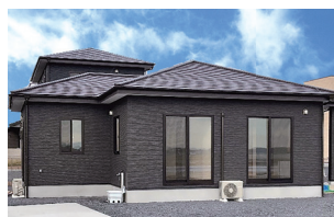
下野市仁良川(2期工事)/2棟 令和5年11月完成(満室)
