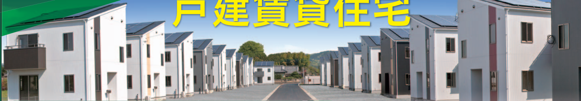
鹿沼市/K様貸家 賃貸施工事例 平成27年5月完成
